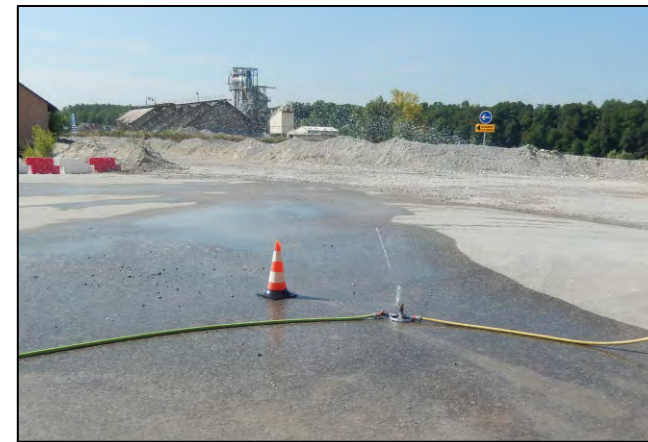
Mise en place de dispositif d'arrosage des pistes et des stocks facilement déplaçable (R)
